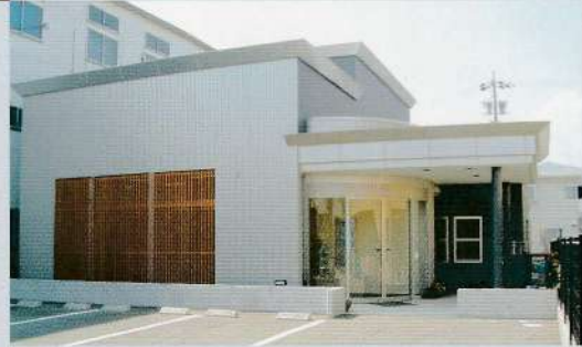
■大きな木の格子窓が外観にアクセントを与えている
