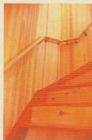
階段の手すり
