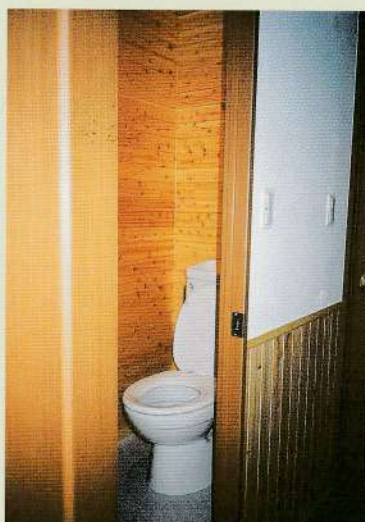
トイレ (ヒノキのムク板張り) ■工事費12万円
