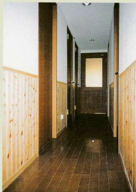
廊下 (両壁ともヒノキのムク板の腰壁) ■工事費14万円
