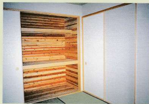
和室押入 (内部はスギのムク板張り) ■工事費20万円
