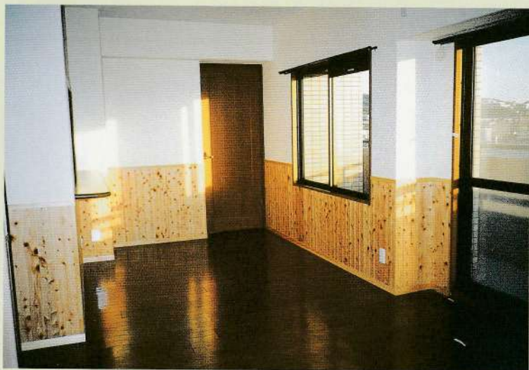
リビング・ダイニング (ヒノキのムク板の腰壁と珪藻土塗り) ■工事費34万円
