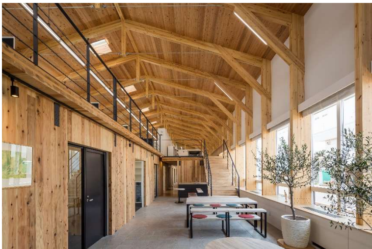
新社屋の内部空間 (張弦梁の集成材門型フレームと CLT の床組)
