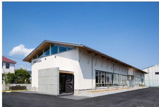
新社屋の南西側外観
