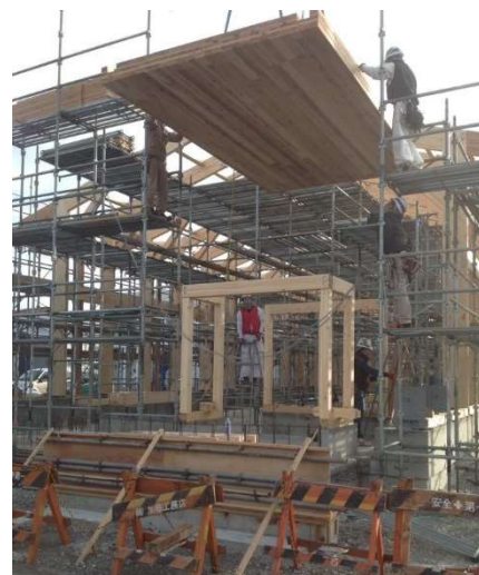
CLT パネルの施工
