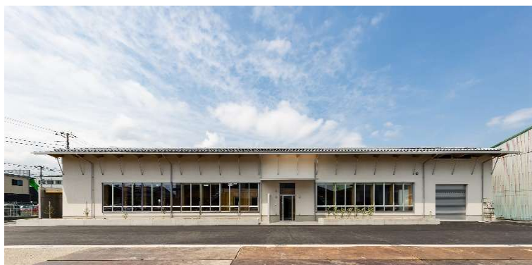
新社屋の南側外観
